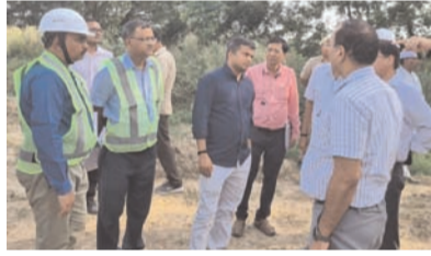
जनपद भ्रमण के दौरान जेवर एयरपोर्ट पहुंचें, जहां नेशनल हाईवे अथॉरिटी ऑफ इंडिया के द्वारा जेवर एयरपोर्ट से आईजीआई तक बनाई जा रही एक्सप्रेस वे का स्थलीय निरीक्षण किया। जिलाधिकारी ने एक्सप्रेस वे निर्माण के लिए किये जा रहे कार्यों का बहुत ही
