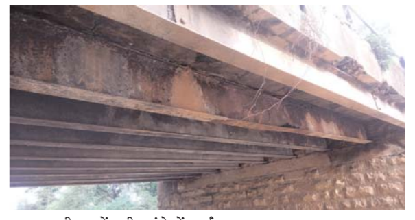
पुल की गाड़ें टूटी, ढांचे में आई दरार नए पुल बनने की बात जोह रहे इस पुल की गाड़ें जंग से गल चुकी हैं। गली हुई जंग लगी गाड़ों के टुकड़े अब नदी में गिरने लगे हैं, जिस ढांचे पर पुल खड़ा है उसमें मोटी दरारे निकल आई हैं। भारी वाहन गुजरते ही भयावह आवाज से लगता है जैसे पुल का कोई हिस्सा टूट गया है। वहीं आसपास कंपन बढ़ी तेजी से होता है। शासन प्रशासन से क्षेत्र वासियों का आग्रह है कि पुल की यथा स्थिति की जांच कर नए पुल का निर्माण कराया जावे जिससे भविष्य में इसी प्रकार की बड़ी दुर्घटना को रोक जा सके।
